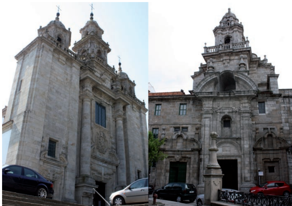
Figura 3 Izquierda: Iglesia de Santiago, 1754-1761. Pontevedra Derecha: Iglesia de Santo Domingo (diseñada en 1763). A Coruña
