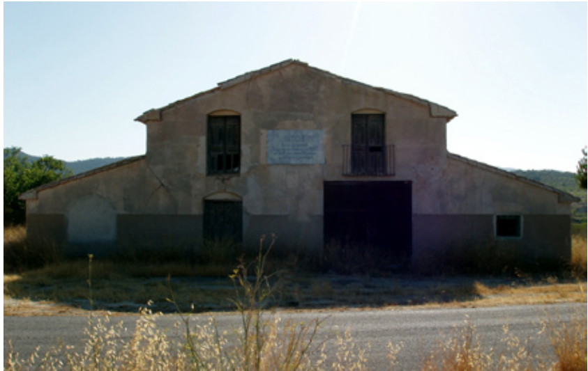
Edificio de bodega y viviendas conocido como “Rosique”, en el término de Mula.
