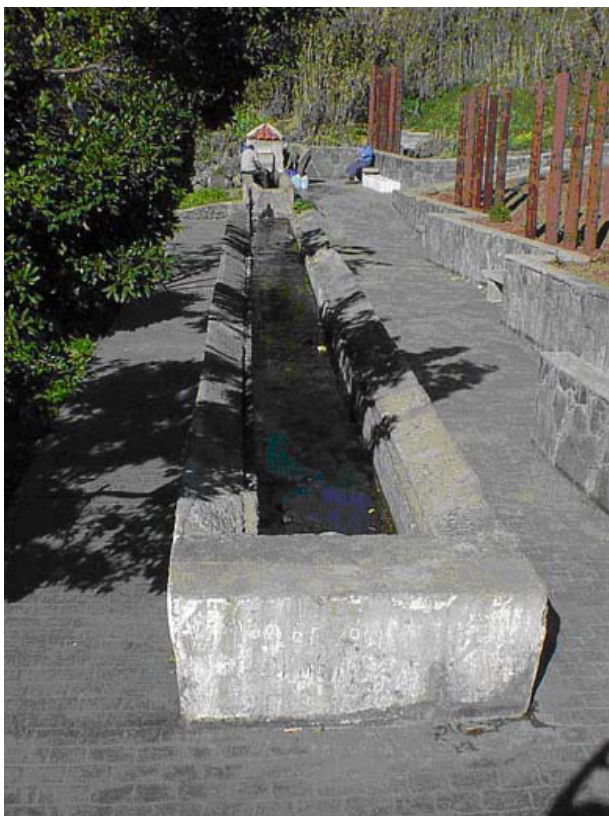
Lavadero del Barranco de la Mina (Utiaca). Vega de San Mateo (Gran Canaria) 2001. Catálogo Arquitectónico. Vega de San Mateo.
