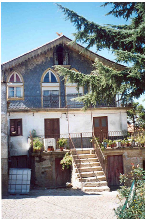
Casa de barcos (estructura de madera)
