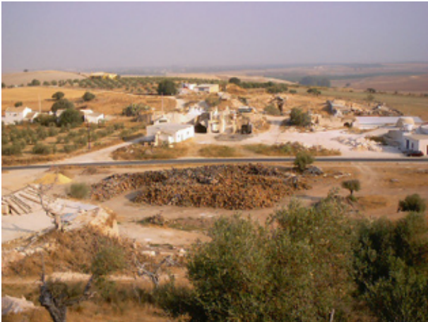
Panorámica de las Caleras de la Sierra
