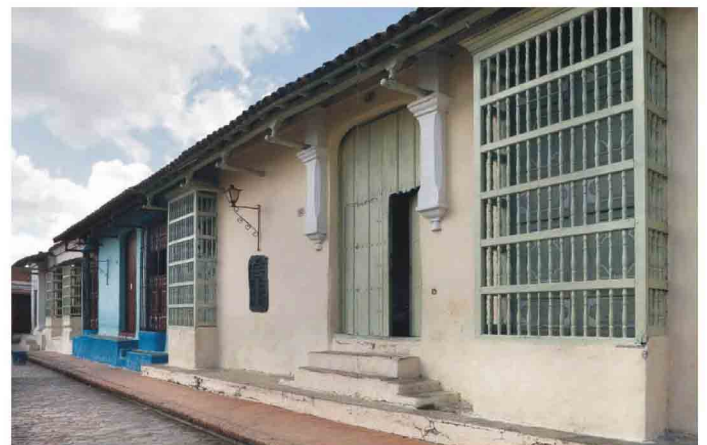
Cuba, vivienda en Camagüey
