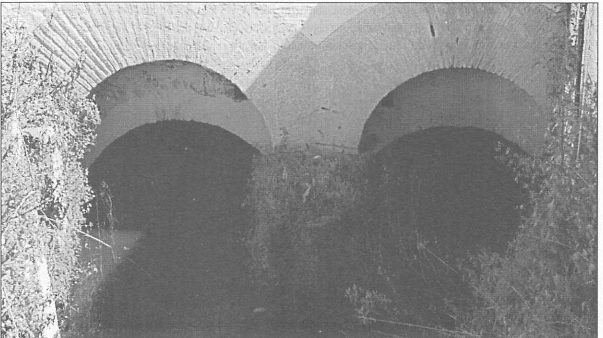
Doble bóveda o cárcavo en cuyo interior se sitúan los rodeznos.
