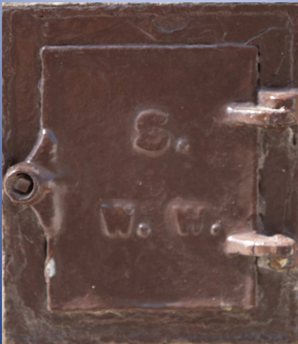
Portezuela de los contadores de agua
