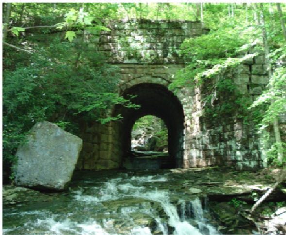
Alcantarilla o Tajea
