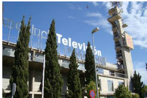
Figura: Instalaciones de RTVA. Canal Sur.
