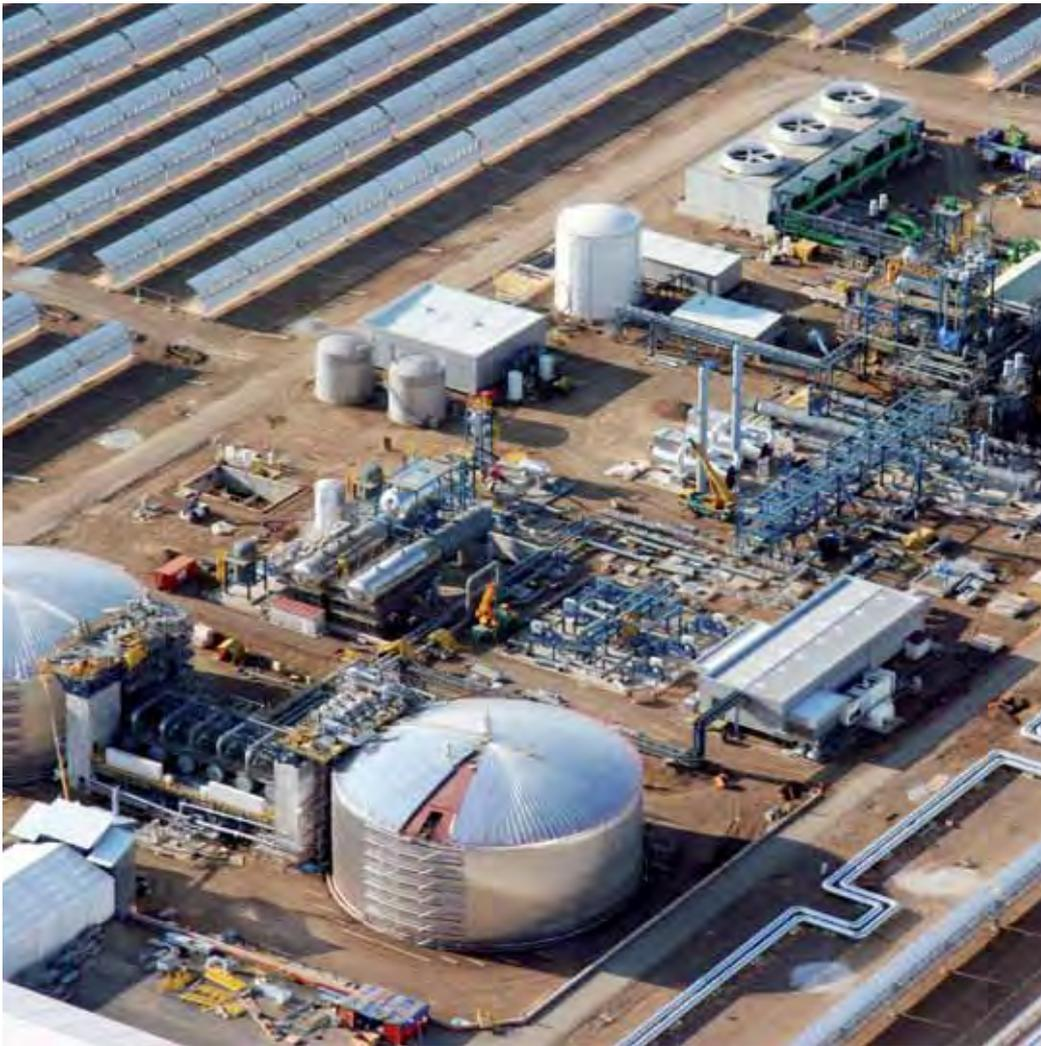
Sobre estas líneas, la isla de potencia de la planta de colectores cilindro parabólicos de ANDASOL 1 en Granada, con los tanques de almacenamiento térmico en la parte inferior izquierda de la imagen, utiliza sales fundidas como tecnología de almacenaje.
