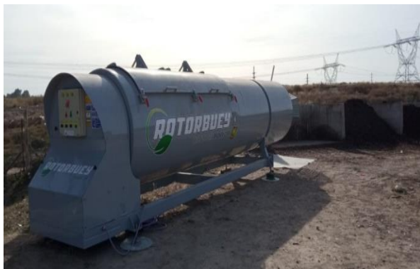
Figura 1. Instalación y puesta en funcionamiento del SCC con RSO urbanos.
