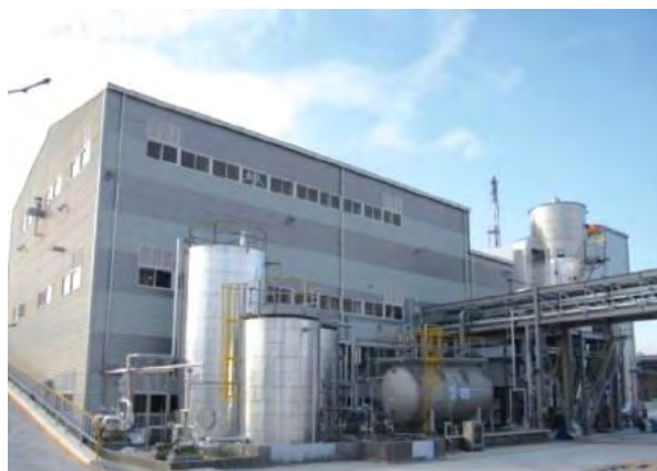
Fig. 3. Primera planta comercial para la síntesis hidrotérmal de \text{LiFePO}_4 en condiciones supercríticas.
