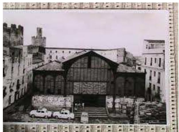
Fot. 2. Vista general del Edificio Metálico antes del traslado
