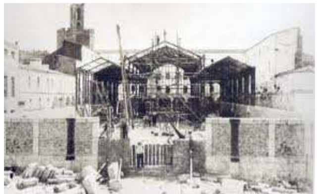
Fot. 1. Construcción del Edificio Metálico
