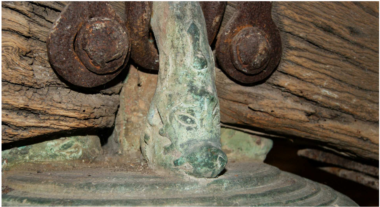
Fig. 3. Detalle de la decoración zoomórfica de la corona o asa. Se observan distintas capas de corrosión y cloruros activos.
