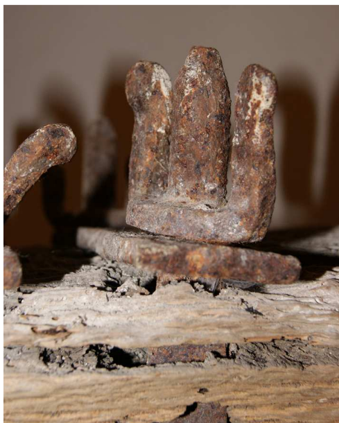
Fig. 4. Detalle del cierre de los tirantes de hierro.
