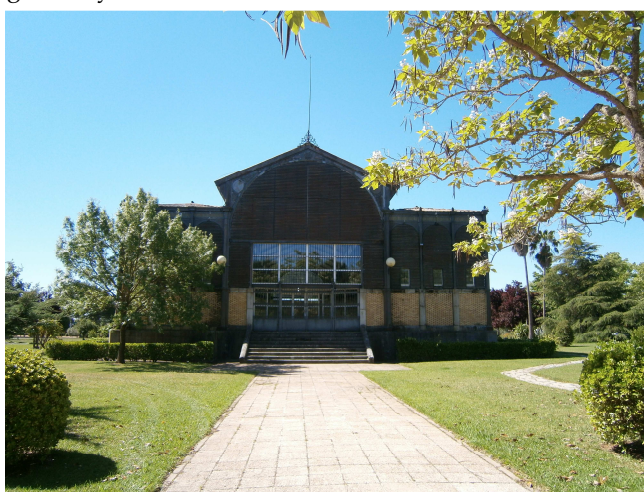
Fot. 4. Vista general del Edificio Metálico en el campus (frente norte)
