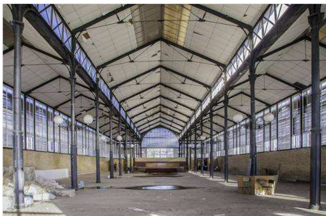
Fot. 6. Vista general del interior de Edificio Metálico
