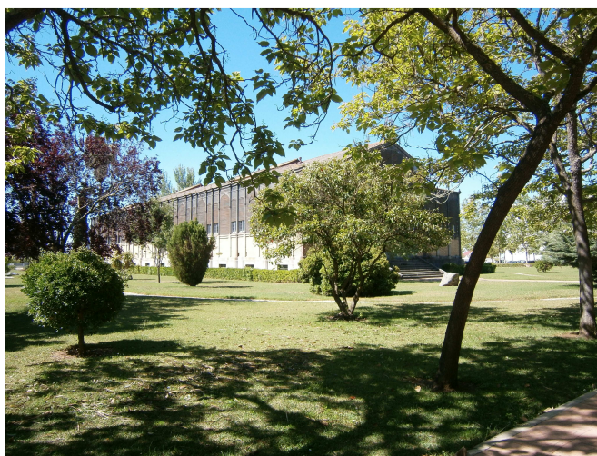
Fot. 7. Vista de la fachada lateral
