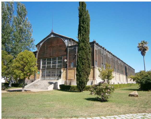
Fot. 5. Vista general del Edificio Metálico (cara sur)
