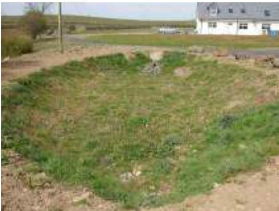
Fig. 5. Depósito de infiltración. Fuente: moir-environmental.co.uk
