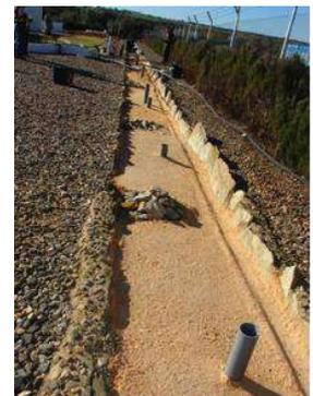
El **mantenimiento del sistema de depuración** requiere de una limpieza anual, inyectando agua en contra corriente para extraer por el punto más bajo los posibles depósitos de fango que hayan podido quedar acumulados en la base tras un año de operación, y así garantizar el funcionamiento de estos sistemas con un aprovechamiento completo del volumen útil. Los grupos de desinfección y presión requerirán de labores de mantenimiento electromecánico cada mes.
