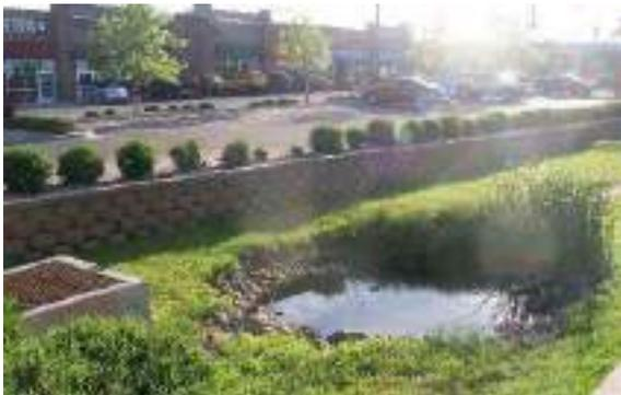
Fig.3. Estanque de retención en City Park (Denver, EEUU). Fuente: EPA
