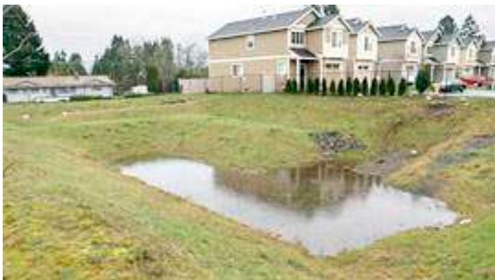
Fig.2. Depósito de infiltración superficial. Fuente: stormwaterpartners.com
