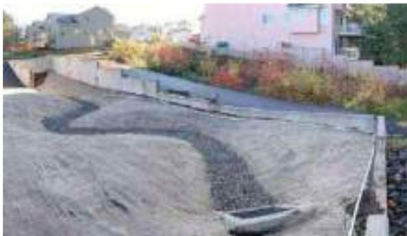
Fig. 2. Dren filtrante sin tubo Fuente: ecoprojecta.es
