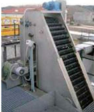
Fig. 5. Tamiz deslizante. Fuente: CEDEX
