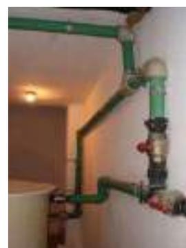
Fig. 22. Depósito auxiliar y by-pass del grupo de presión del Bloque N°29. (Fuente: Elaboración propia)
