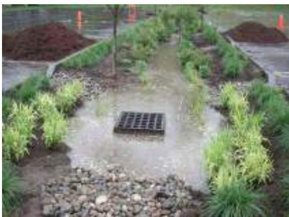
Fig.5. Elemento para la salida del exceso de volumen por desbordamiento.
