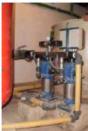
Fig. 21. Bombas del grupo de presión del Bloque N°29. (Fuente: Elaboración propia)
