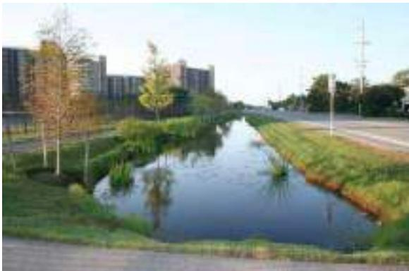
Fig. 6. Cuneta verde húmeda. South Pennsylvania (U.S.A.) Fuente: Anchorage Canal Retrofit Project
