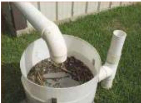
Fig. 4. Trampa de sólidos. Fuente: Phillips, V.
