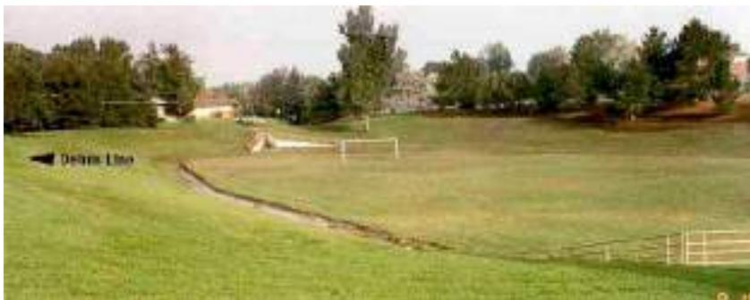
Fig. 5. Depósito de detención en área deportiva con canal de bajo flujo. Fuente: udfcd.org.
