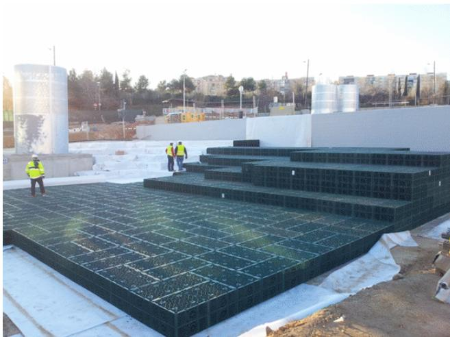
Fig. 3. Depósito de infiltración subterráneo en Avda. Estatut. Barcelona. Fuente: ecohabitar.org.
