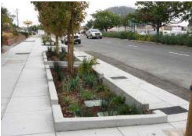
Fig.3. Área de bioretención.
