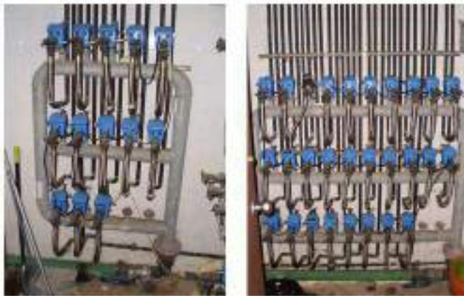
Fig. 25. Dos batería de contadores del Bloque N°35 (PB+10). (Fuente: Elaboración propia)
