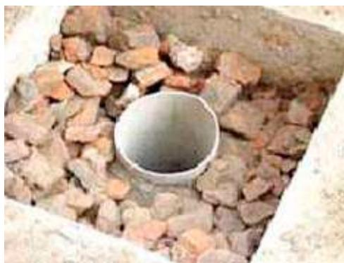
Fig. 2. Pozo de infiltración con relleno granular.
