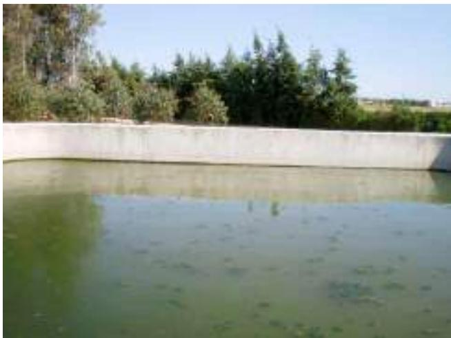
Figura 2. Laguna Anaerobia. Carrión de los céspedes.
