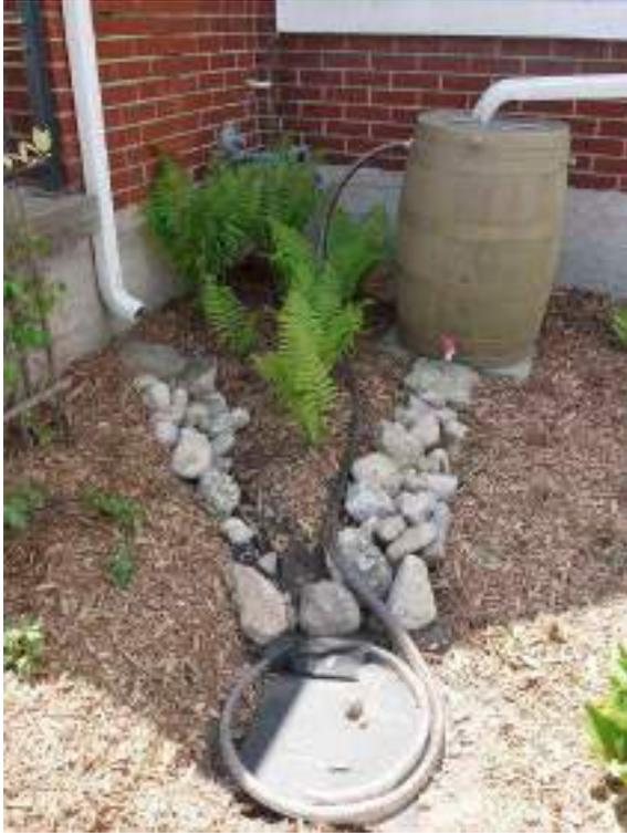
Fig. 5. Pozo de infiltración en patio de vivienda. Fuente: Reep Green Solutions.
