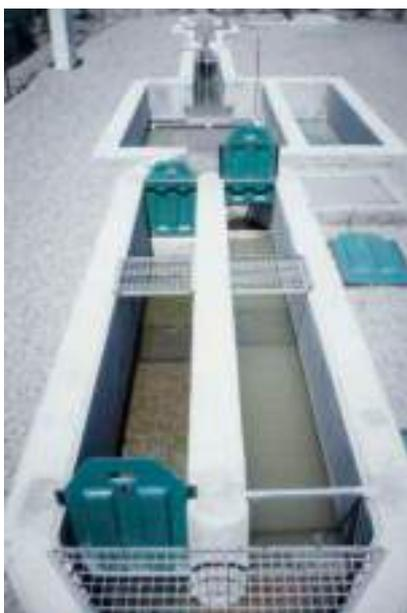
Figura 3. Esquema de desarenador aireado. Fuente: CEDEX.
