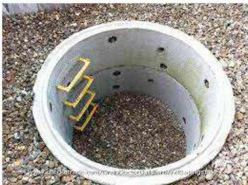
Fig. 4. Pozo de infiltración con cámara.
