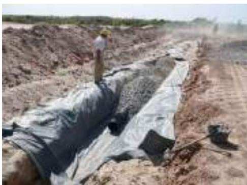
Fig. 3. Drenaje con tubo. Zona Franca (Uruguay). Fuente: concret-nor.com
