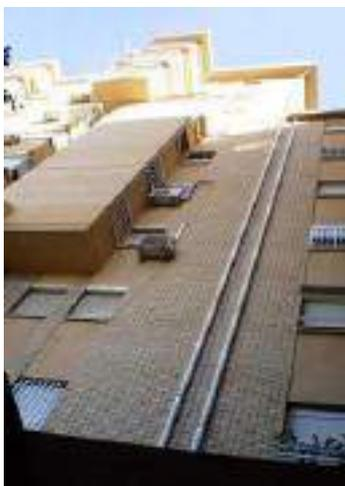
Fig. 27. Bajantes de recogida de aguas pluviales en cubierta. (Fuente: Elaboración propia)
