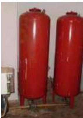
Fig. 23. Depósitos de presión del Bloque N°35. (Fuente: Elaboración propia)
