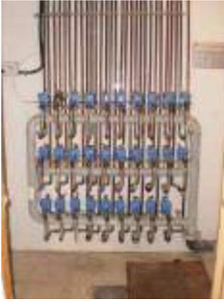
Fig. 24. Batería de contadores del Bloque N°29 (PB+7). (Fuente: Elaboración propia)
