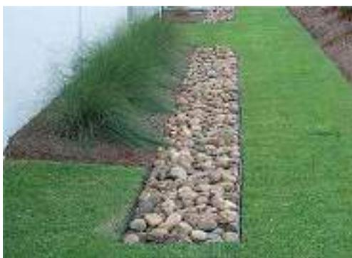
Fig. 3. Zanja de infiltración en Lago Oswego (Oregón, EEUU). Fuente: R. Pitt 2005.
