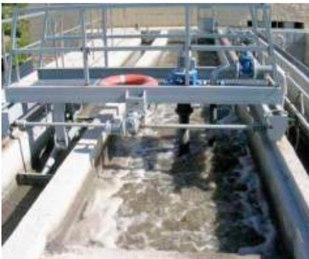
Figura 3. Desengrasador-desarenador con puente móvil. Fuente: CEDEX
