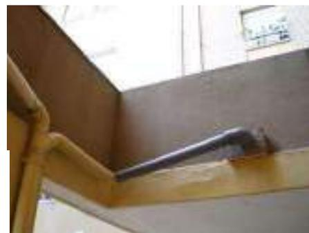
Fig. 28. Recogida de pluviales de la cubierta de planta baja. (Fuente: Elaboración propia)
