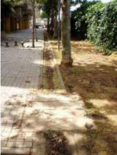
Fig. 15. Arqueta de registro de telecomunicaciones que intercepta canalón de drenaje. (Fuente: Elaboración propia)
