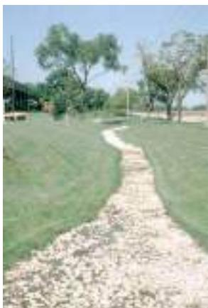
Fig.2. Zanja de infiltración (Gales) Fuente: sudswales.com
