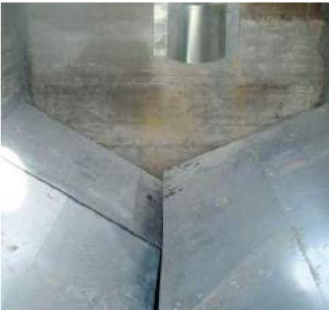
Figura 4. Interior de Tanque Imhoff. Fuente: CEDEX, 2010.
