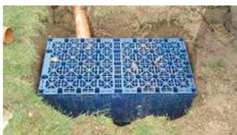
Fig. 3. Pozo de infiltración con módulo geocelular.
