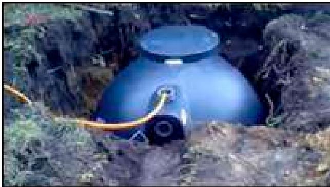
Figura 3: Instalación fosa séptica prefabricada (Grupo TAR, 2013).
