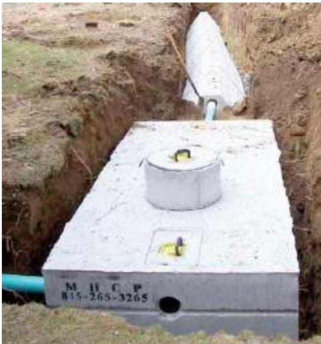
Figura 4. Fosa séptica prefabricada en hormigón. (Cedex, 2010)
