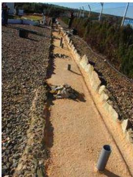
El agua gris efluente se incorpora al CAS y es tratada a través del mismo en régimen subsuperficial. Los pozos situados en el primer y último metro de cada uno de los tramos que componen el canal permiten el mantenimiento del mismo, que debe realizarse anualmente. Dicho mantenimiento consistirá en la extracción de los fangos depositados en la base tras una inyección de agua en contracorriente por medio de una manguera a la presión de circulación por la red.
