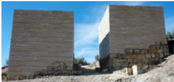
[27]. Puerta de la muralla de Torreparedones, Baena, Córdoba (fot. M. a del Valle Gómez de Terreros, 2015).
