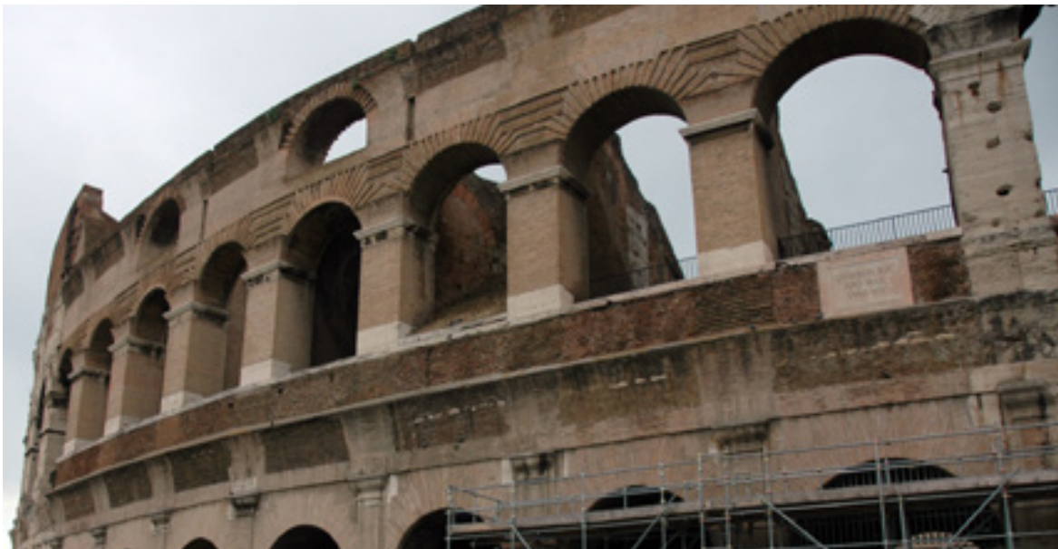
[8]. Arquerías que completan el sector sureste del Coliseo, terminadas a mediados del siglo XIX (fot. M. a del Valle Gómez de Terreros, 2014).
