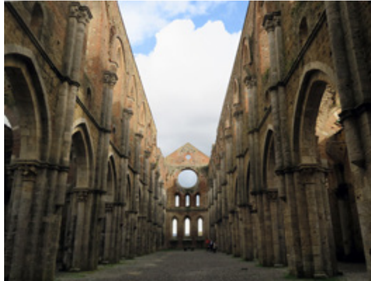
[14]. Abadía de San Galgano, en la Toscana, estado actual (fot. M. a del Valle Gómez de Terreros, 2016).
