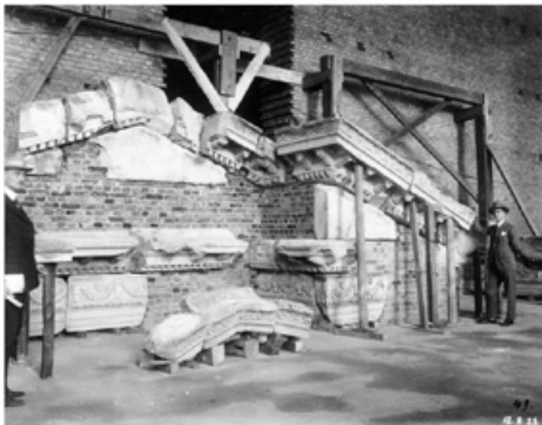
[23]. Reconstrucción de la puerta del Mercado de Mileto en el Pergamonmuseum (frontón central), 12 de septiembre de 1925, Zentralarchiv der Staatlichen Museen zu Berlin - Preußischer Kulturbesitz, ( https://goo.gl/hHOVyX , https://goo.gl/QtuOoD ).
