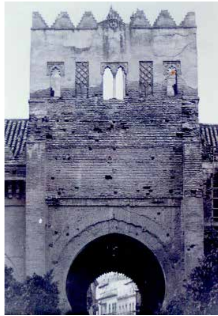
FIG. 5. Aspecto que presentaron las huellas del tejeroz entre 1954 y 1968, cuando la escalera ya ha desaparecido.
