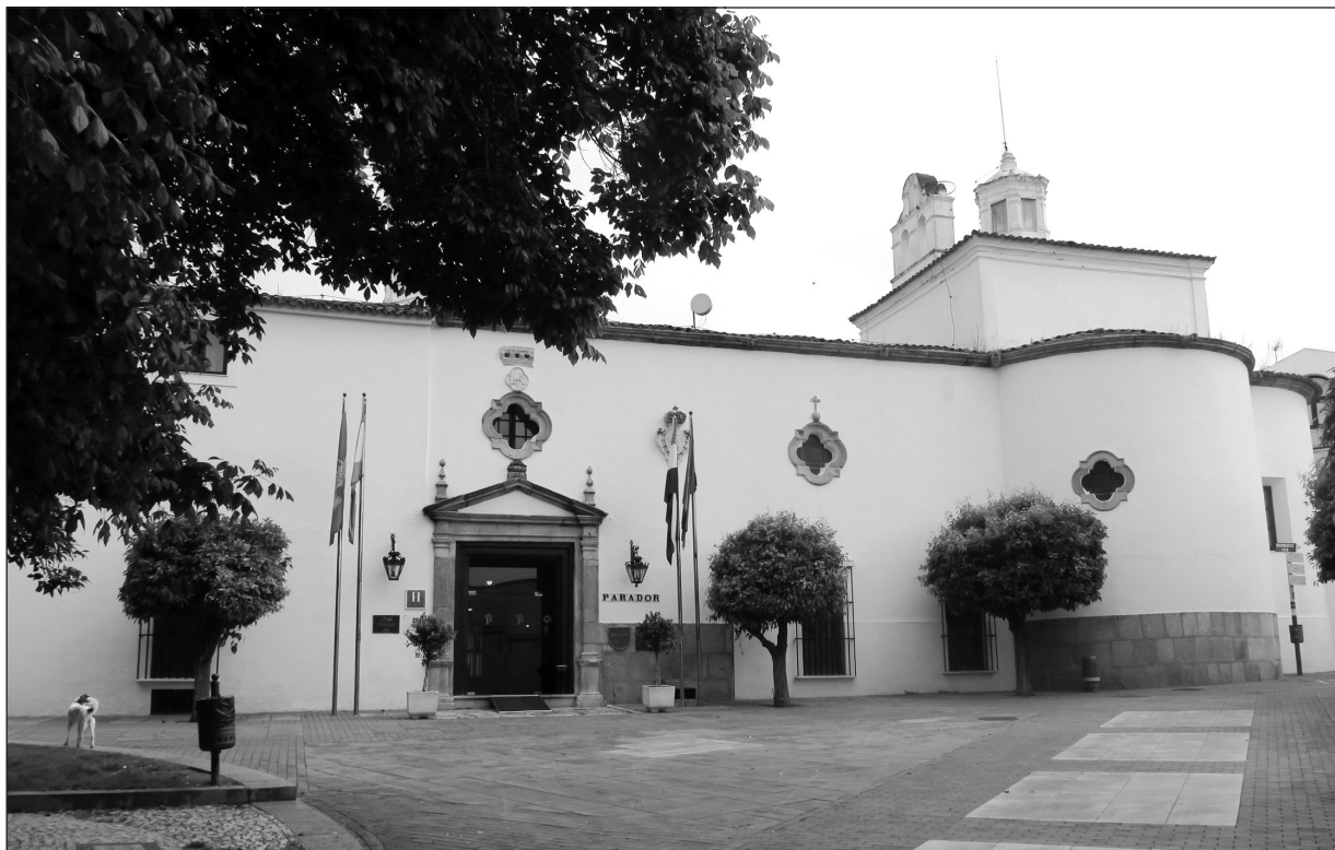
Figura 1 Fachada principal del parador de Mérida, en su estado actual
