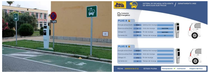
Ubicado entre los edificios 7 y 9. Aparcamiento P2 y controlado por SCADA Power Studio.
