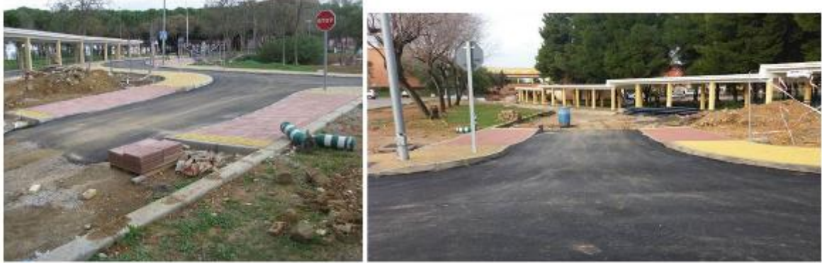
Reforma de entrada y acerado en calle de mantenimiento – Lorenzo Rodríguez.
