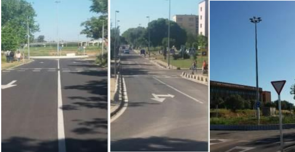
Obras de adecuación en viales y rotondas (CABD-DOS HERMANAS/BIBLIOTECA).
