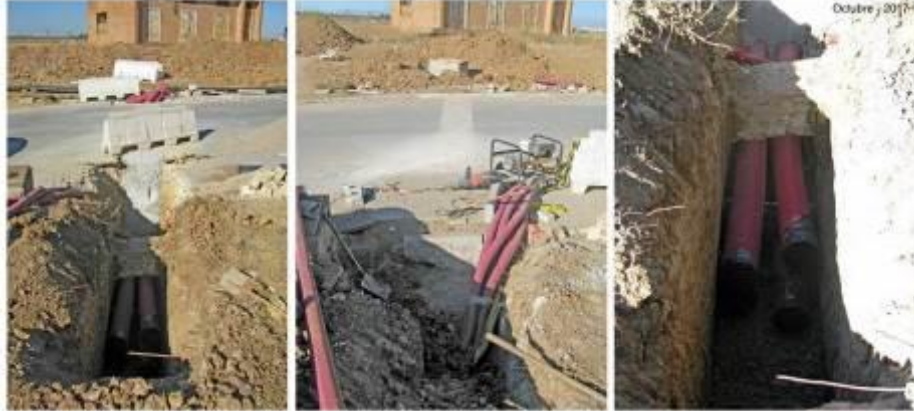
Reforma de canalizaciones de Media y Baja Tensión en CTP02, altura CABD.
