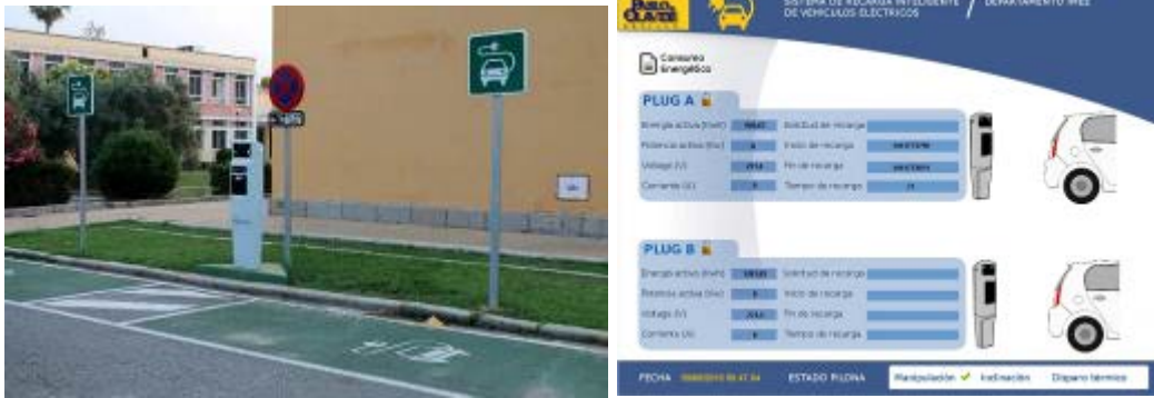
Ubicado entre los edificios 7 y 9. Aparcamiento P2 y controlado por SCADA Power Studio.
