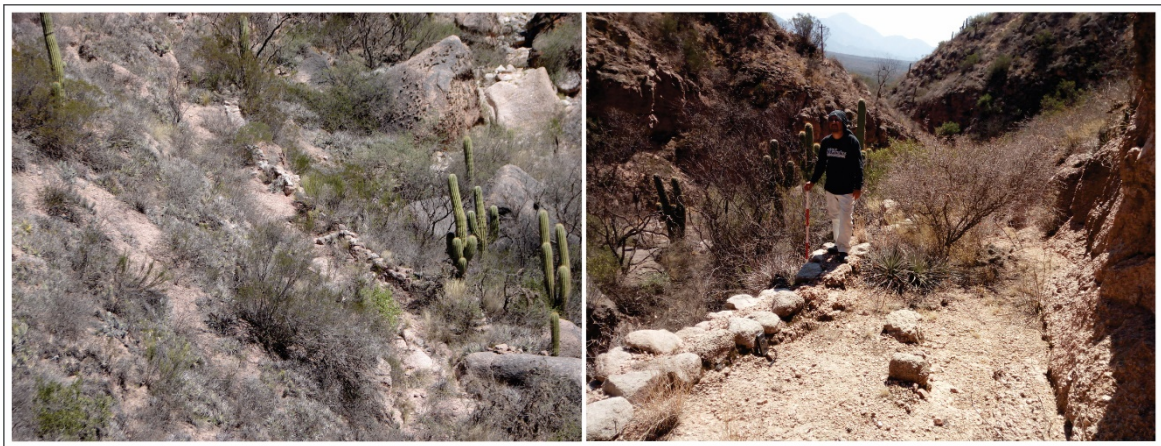
Figura 6: Camino incaico con talud, excavación ladera adentro y muro de protección localizado próximo a la Cuesta de Zapata. Fuente: fotografías de Reinaldo A. Moralejo.
