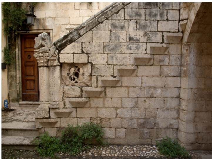
Fig. 4. Siracusa, ex palazzo dell'Orologio, la scala a cielo aperto.
