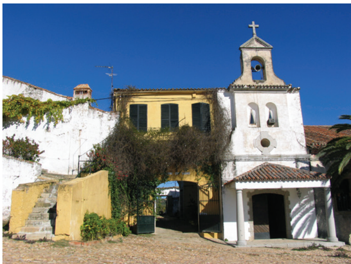
Fig. 3. Fachada principal de la capilla del Cortijo del Rincón.
