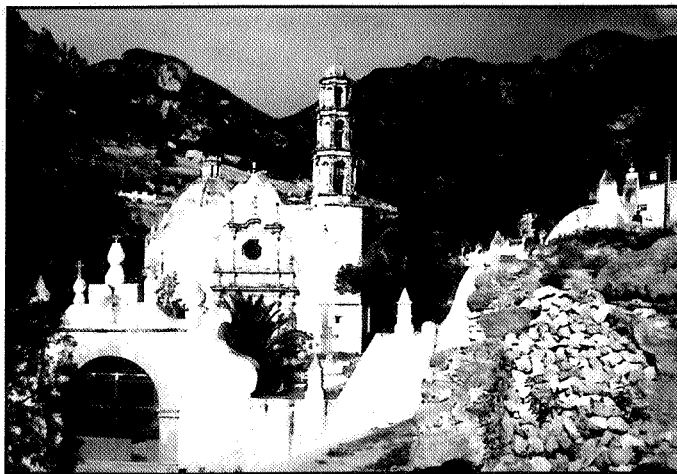
Santuario Mapethé, Hgo. 1990. Vista del frente del edificio, emplazado en terreno agreste y de vegetación desértica.
