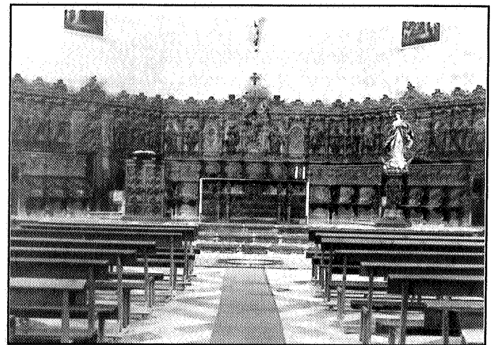
Foto nº 4. Aspecto que ofrece la sillería una vez finalizado su traslado. Se aprecia la mesa del altar, el ambón y los óculos como elementos de nueva ejecución; así como la reutilización del pie del facistol.
