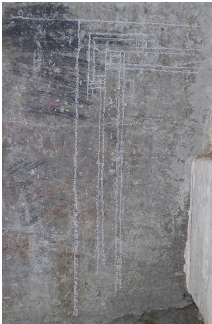
Fig. 9. Montea n° 5. Vano adintelado. Fotografía de la autora.
