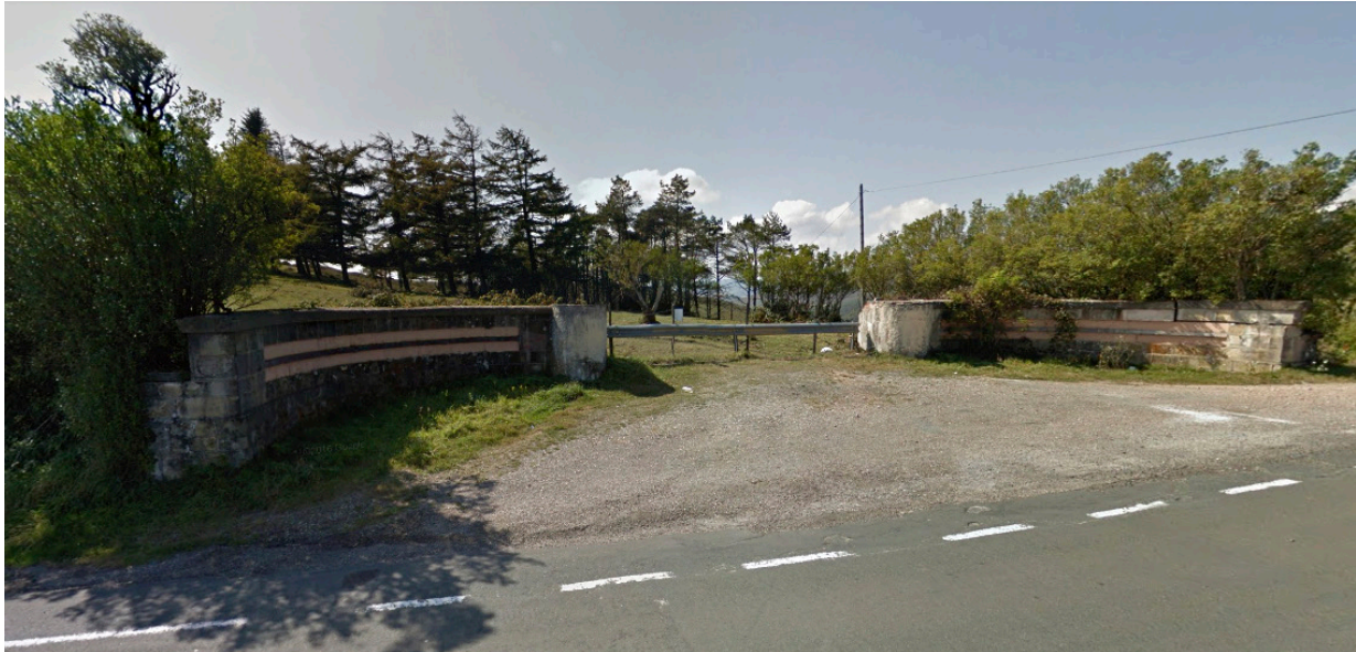
Fig. 3. Estado actual de la entrada monumental. Foto autor. 13-07-2017.
