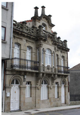
Casa de Manuel Martínez, 1916. Ponte Caldelas, Pontevedra.
