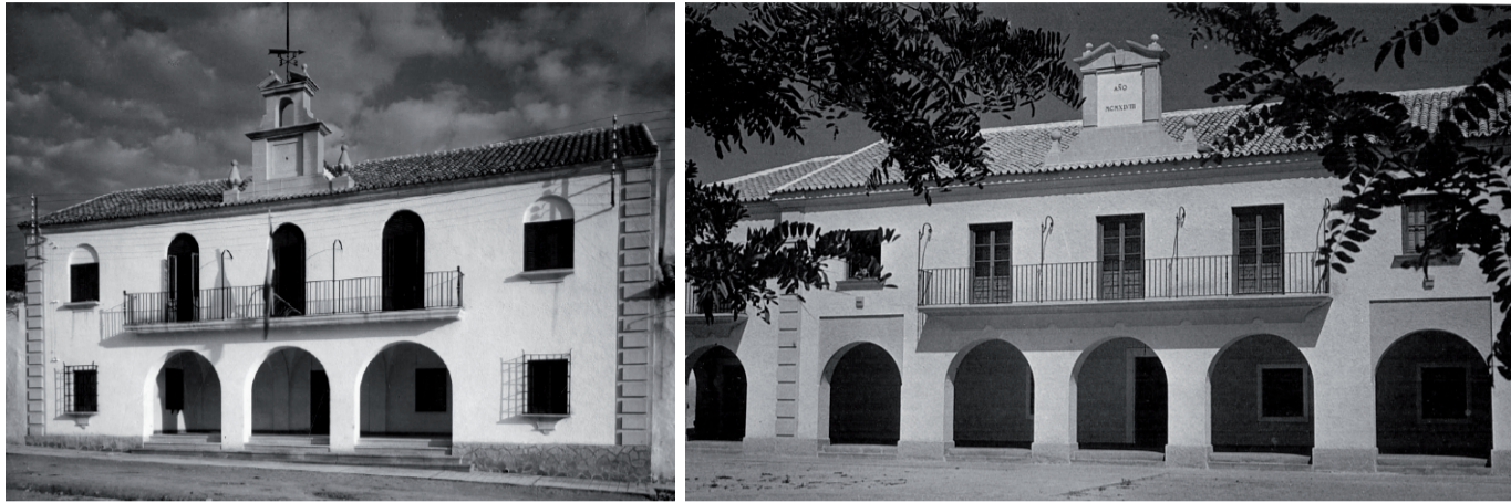
Fig. 5. Ayuntamientos de Santiago de Calatrava e Higuera de Calatrava (Fotografías en la revista Reconstrucción , no. 85, agosto-septiembre 1948).
