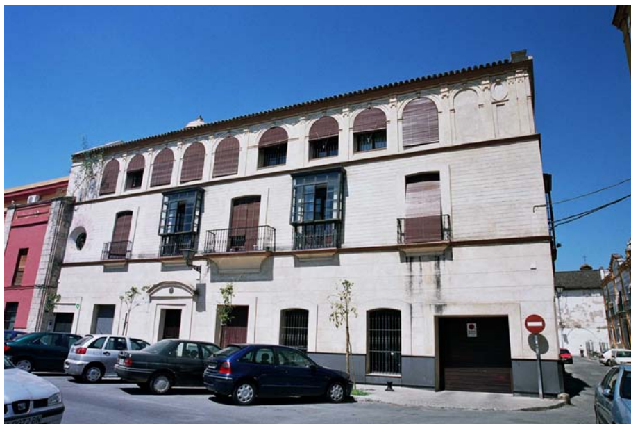
Lám. nº 4.- Fachada del Colegio en la calle Jesús del Gran Poder esquina a calle Becas. Estado actual. Fotografía: Inmaculada Carrasco Gómez y Antonio Martín Pradas.
