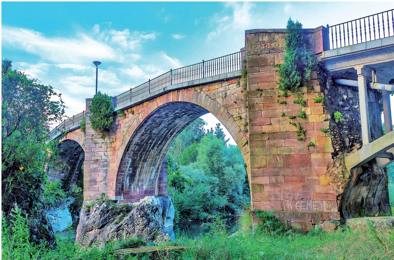
Fig. 5. Puente de Ganzo sobre el río Saja-Besaya, 1763-1765.
