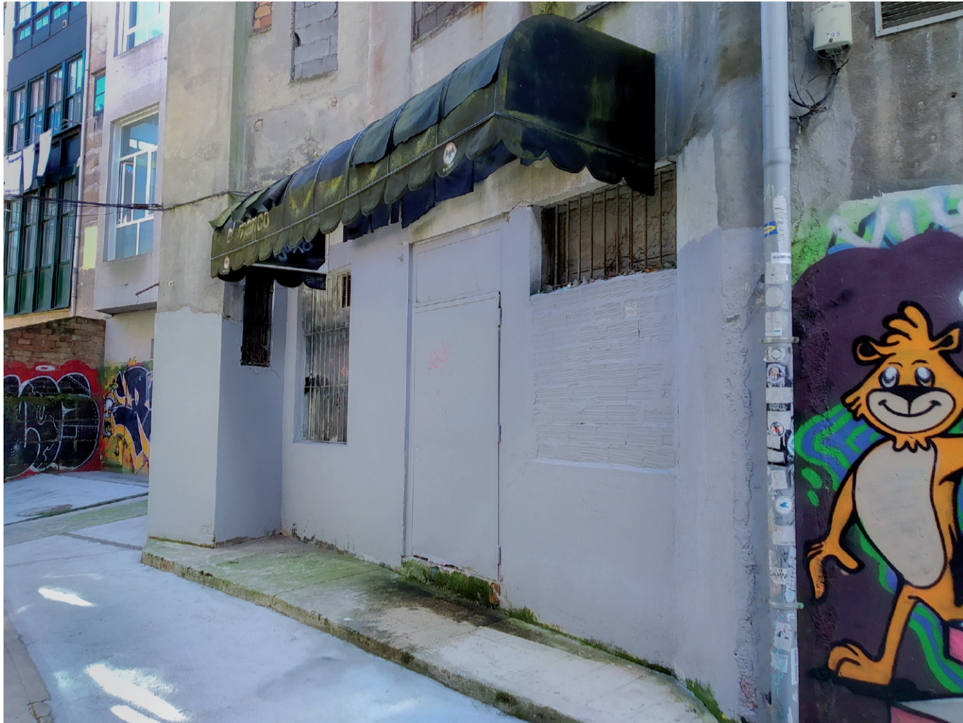
Fig. 2. Salida de emergencia de El Manco pintada de gris. (© Alberto Santos-Hermo)
