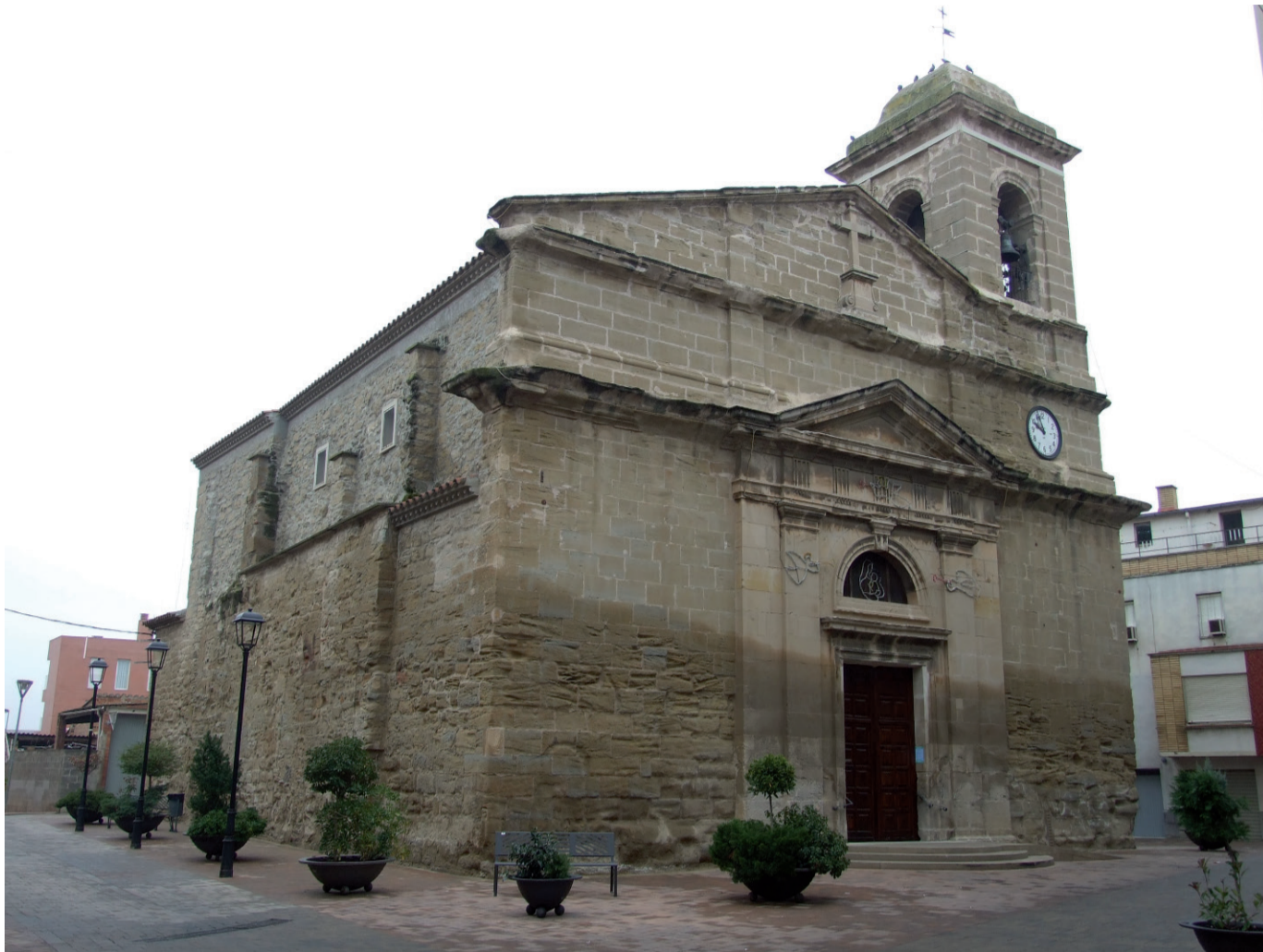
Fig. 1. Antonio Losada, iglesia parroquial de Torrefarrena , 1799. Lleida. © Fotografía: Isidro Puig Sanchis.
