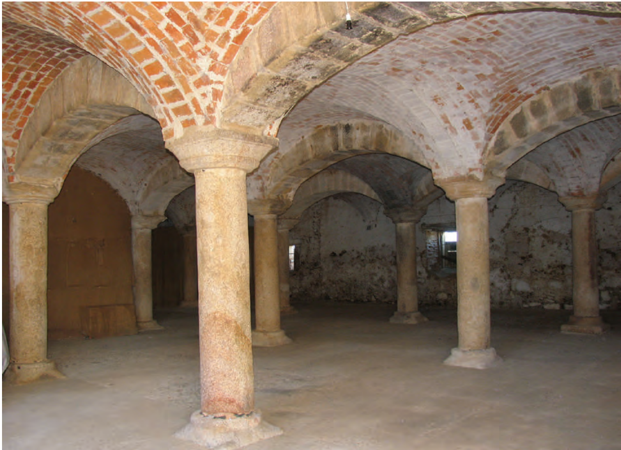
Fig. 6. Bodega para el almacenamiento de aceite del Cortijo del Rincón.
