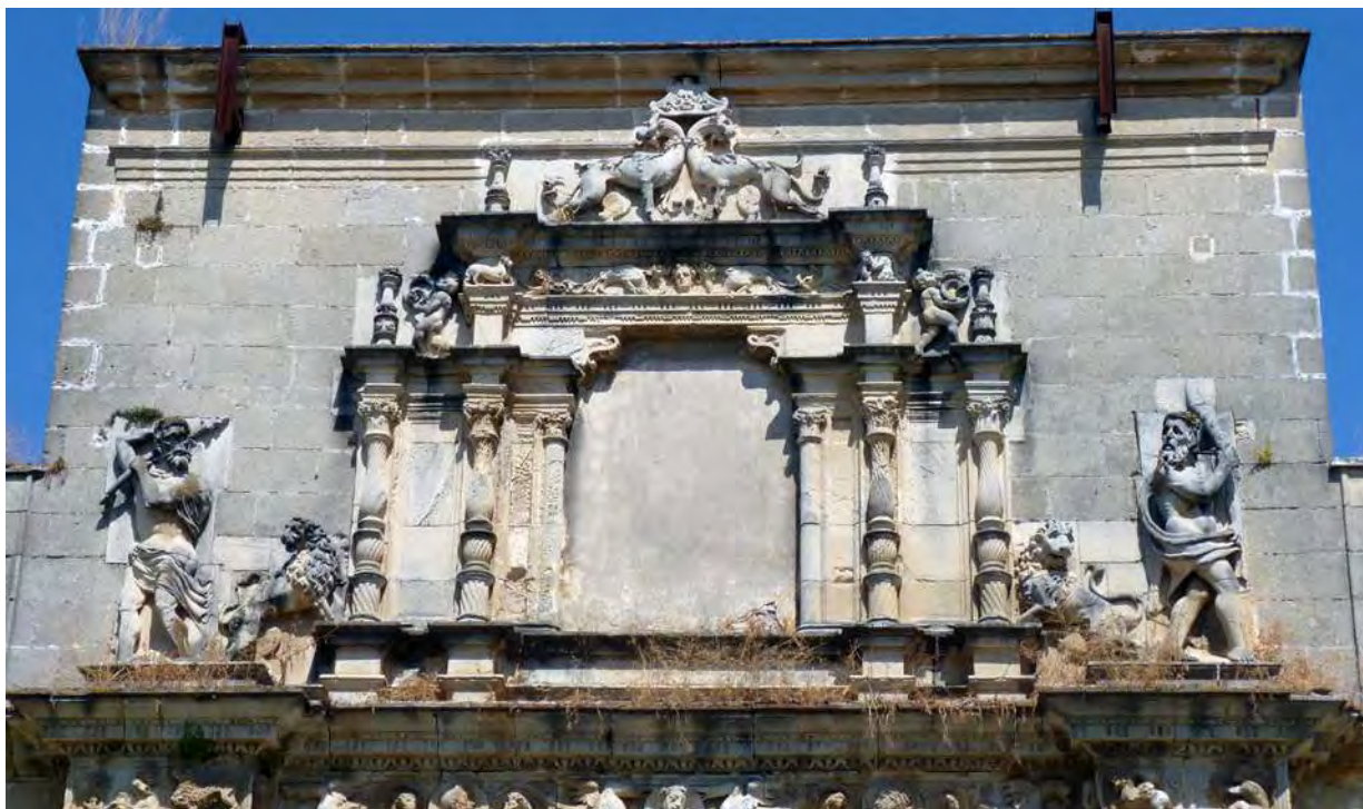
Fig. 6. Detalle de la fachada del Palacio Riquelme, Jerez de la Frontera.
