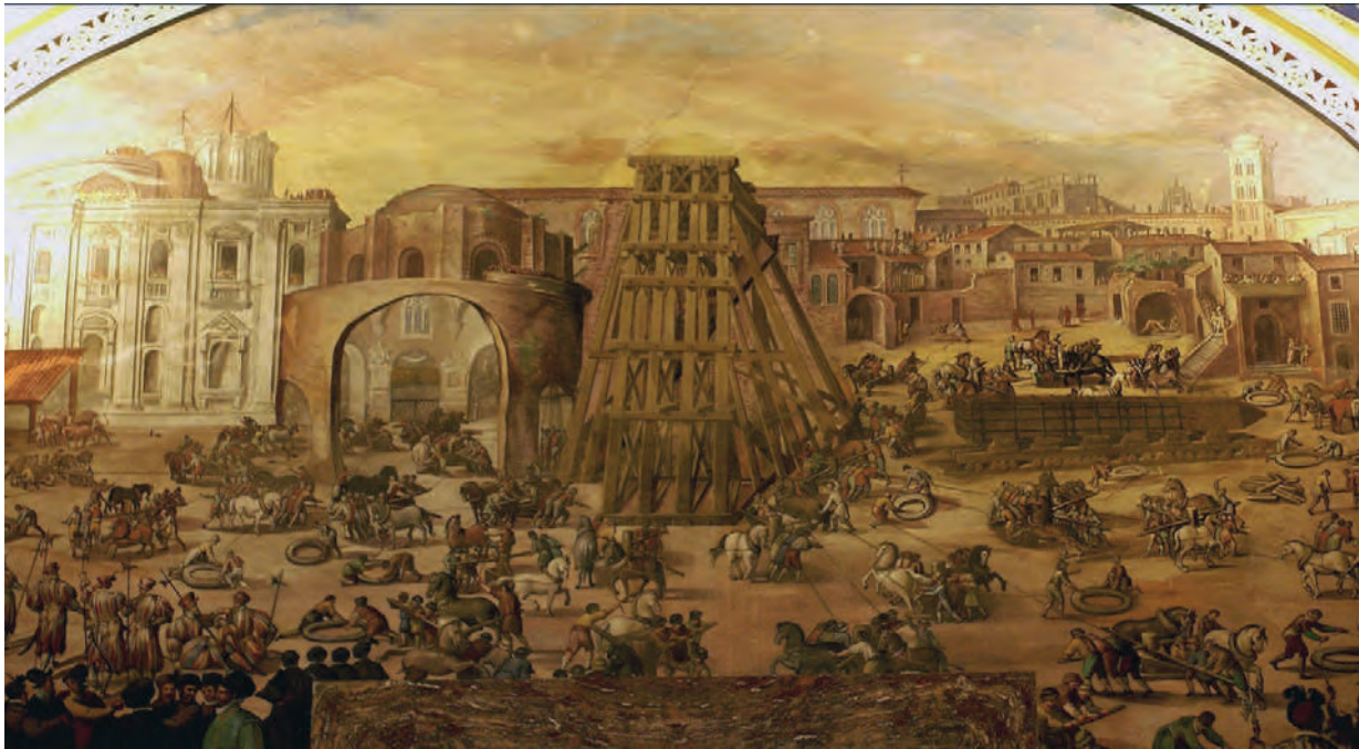
Fig. 8. Detalle del fresco de las estancias sistinas de la Biblioteca Vaticana, con escena del traslado del obelisco Vaticano. Al fondo se aprecia la cúpula de San Pedro en construcción © Musei Vaticani. Roma.
