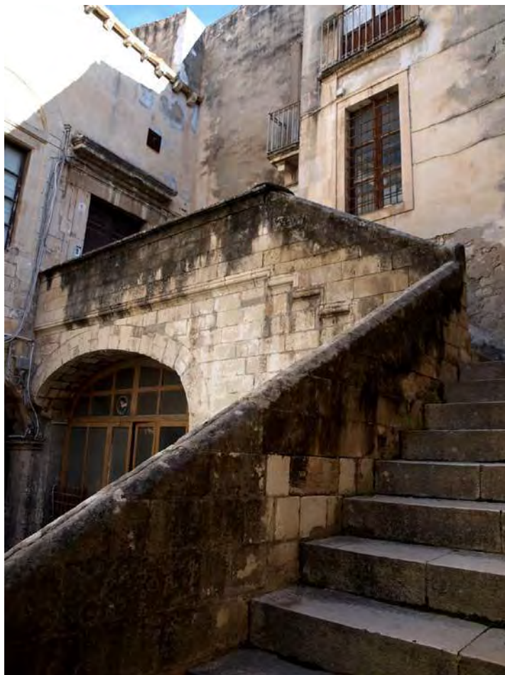
Fig. 5. Siracusa, Palazzo Zappata-Gargallo, particolare della scala a cielo aperto.
