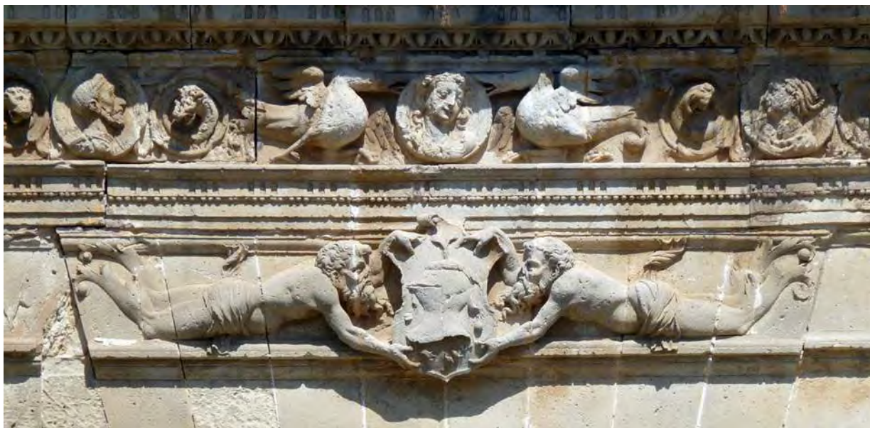
Fig. 4. Detalle de la fachada del Palacio Riquelme, Jerez de la Frontera.
