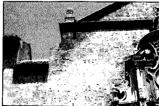
Fotografía 7. Decoración imitando despiece de sillería sobre auténticos sillares de piedra en la Iglesia de los Santos Justo y Pastor de Granada, siglo XVII (Ascensión Ferrer, 1993).
