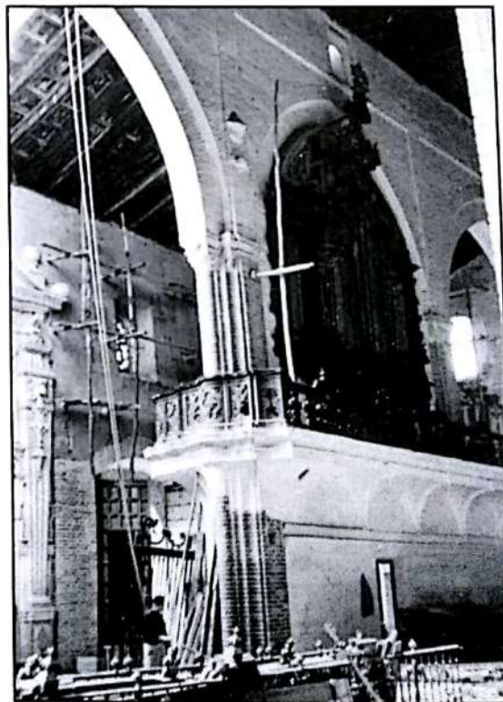
Trabajos de desmantelamiento del coro, observando el órgano aún en su antigua ubicación.
