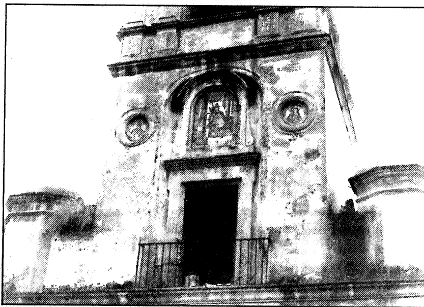
Torre de la iglesia de San Isidoro, Sevilla. Detalle del primer cuerpo.
