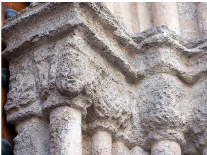
Fig. 7. Portada principal de la iglesia de San Julián. Detalle de la ornamentación de la imposta lateral derecha (R. Cómez).
