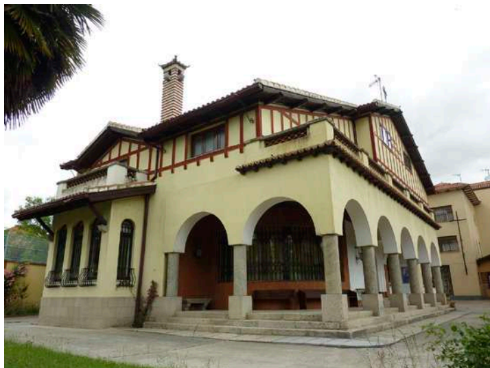
Fig. 10. Fachada del edificio del chalet de Andrés García Blanco, denominado La Pérgola . 1940. Arquitecto: Ricardo Pérez Fernández. Situado entre las avenidas de Raimundo de Borgoña y de la Merced. Foto: Sara Núñez.
