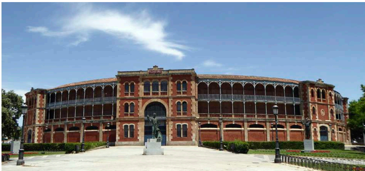
Fig. 4. Fachada de la Plaza de toros La Glorieta. 1892. Arquitecto: Mariano Carderera Ponzán. Situada entre las Avenidas de la Merced y de San Agustín. Foto: Sara Núñez.
