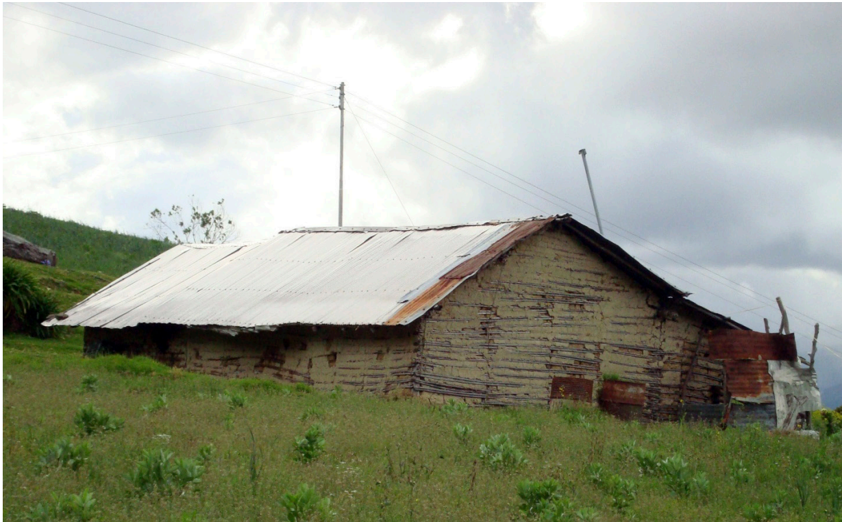
Fig. 8. Vivienda construida con bahareque y techo de zinc en sustitución del carrizo y la teja. Paramito Alto, 2005. (Fotografía de Nelly Mejías).
