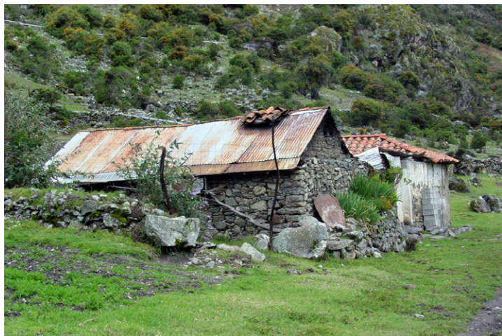
Fig. 9. Vivienda de dos piezas construidas con materiales diversos: piedra, bahareque, teja y zinc en techos. Paramito Alto, 2005. (Fotografía de Nelly Mejías).
