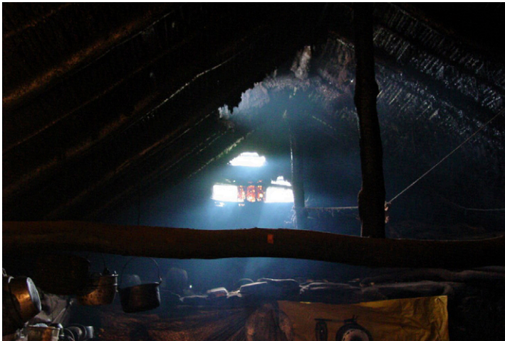
Fig. 10. Espacio de la cocina que contiene el fogón con una única abertura en la pared para desalojar el humo de la leña. Paramito Alto, 2015. (Fotografía de Nelly Mejías).
