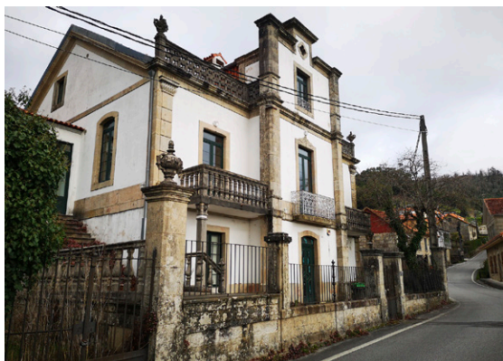
Casa de Raquel Moreira Marín, 1920. Ponte Caldelas, Pontevedra.
