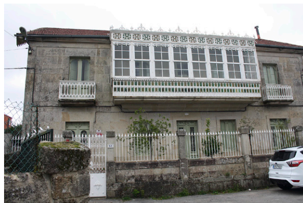
Casa de Lino Bouzas Bouzas, 1915. Anceu. Ponte Caldelas, Pontevedra.
