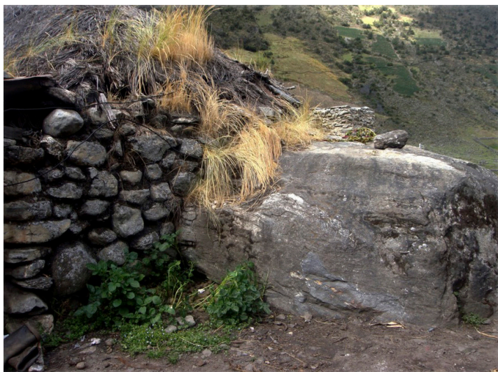
Fig. 5. Vivienda construida adosada a una piedra para aprovechar el calor en la noche. Paramito Alto, 2005. (Fotografía de Nelly Mejías).
