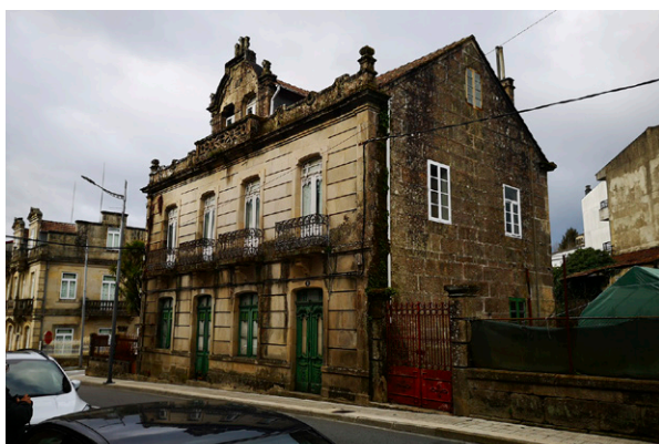
Casa de Manuel Piñeiro Boulosa, 1920. Ponte Caldelas, Pontevedra.
