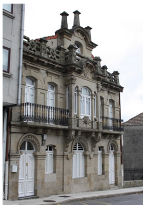
Casa de Manuel Martínez, 1916. Ponte Caldelas, Pontevedra.
