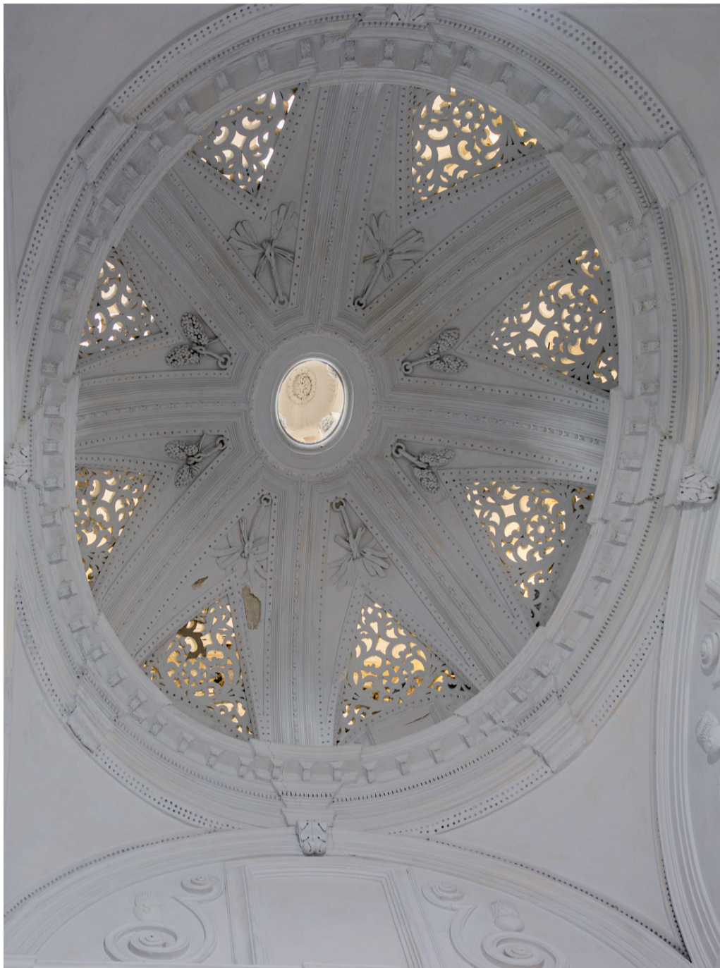
Fig. 3. Bóveda de la escalera (Fotografía de Lorenzo Alonso de la Sierra).
