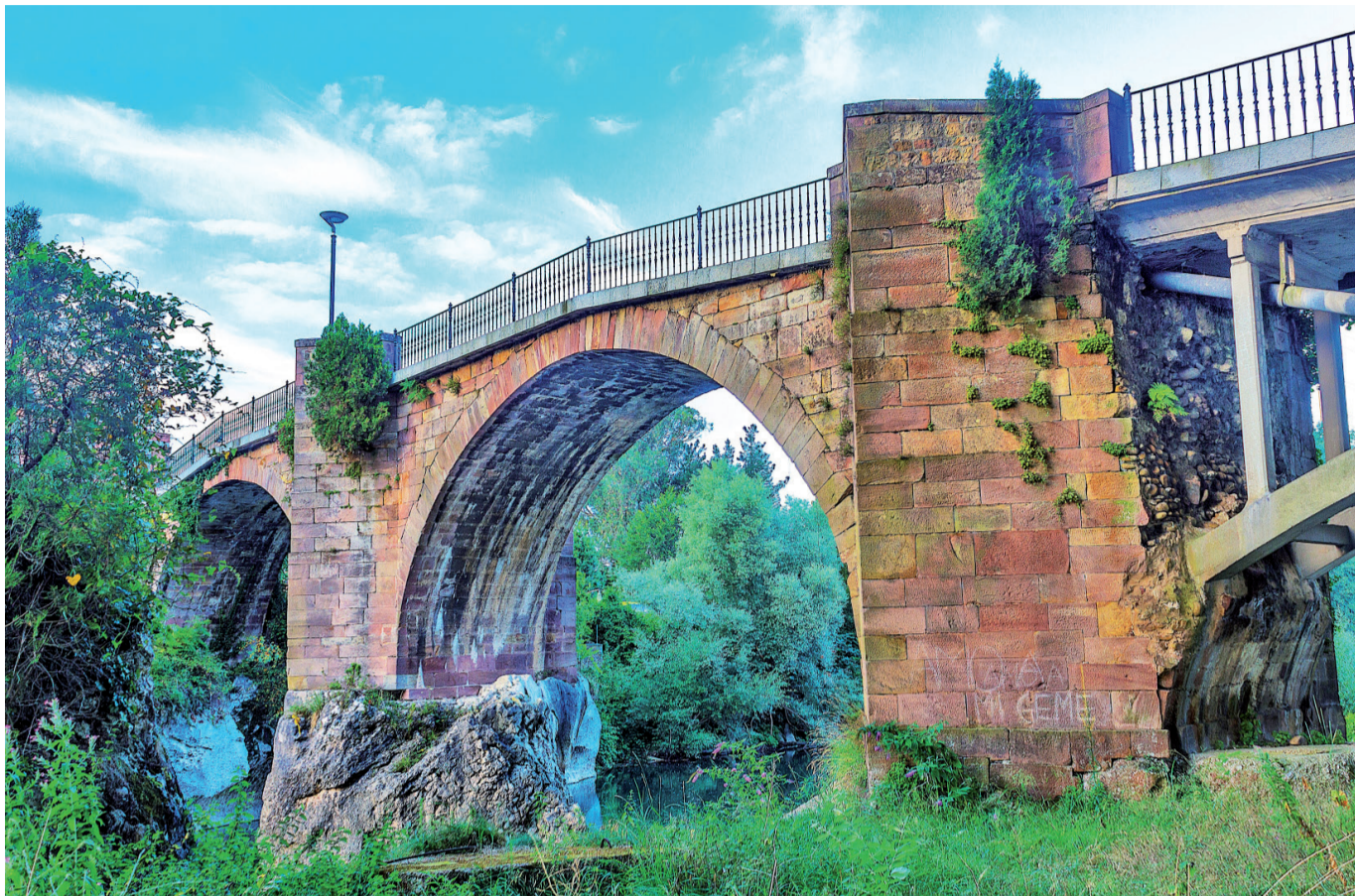
Fig. 5. Puente de Ganzo sobre el río Saja-Besaya, 1763-1765.
