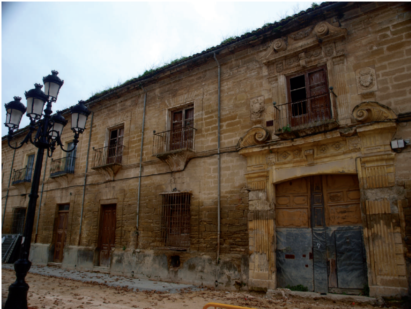
Fig. 8. Fachada del palacio de los marqueses de Priego, siglo XVI. Montilla, Córdoba. © Fotografía: María del Amor Rodríguez Miranda.
