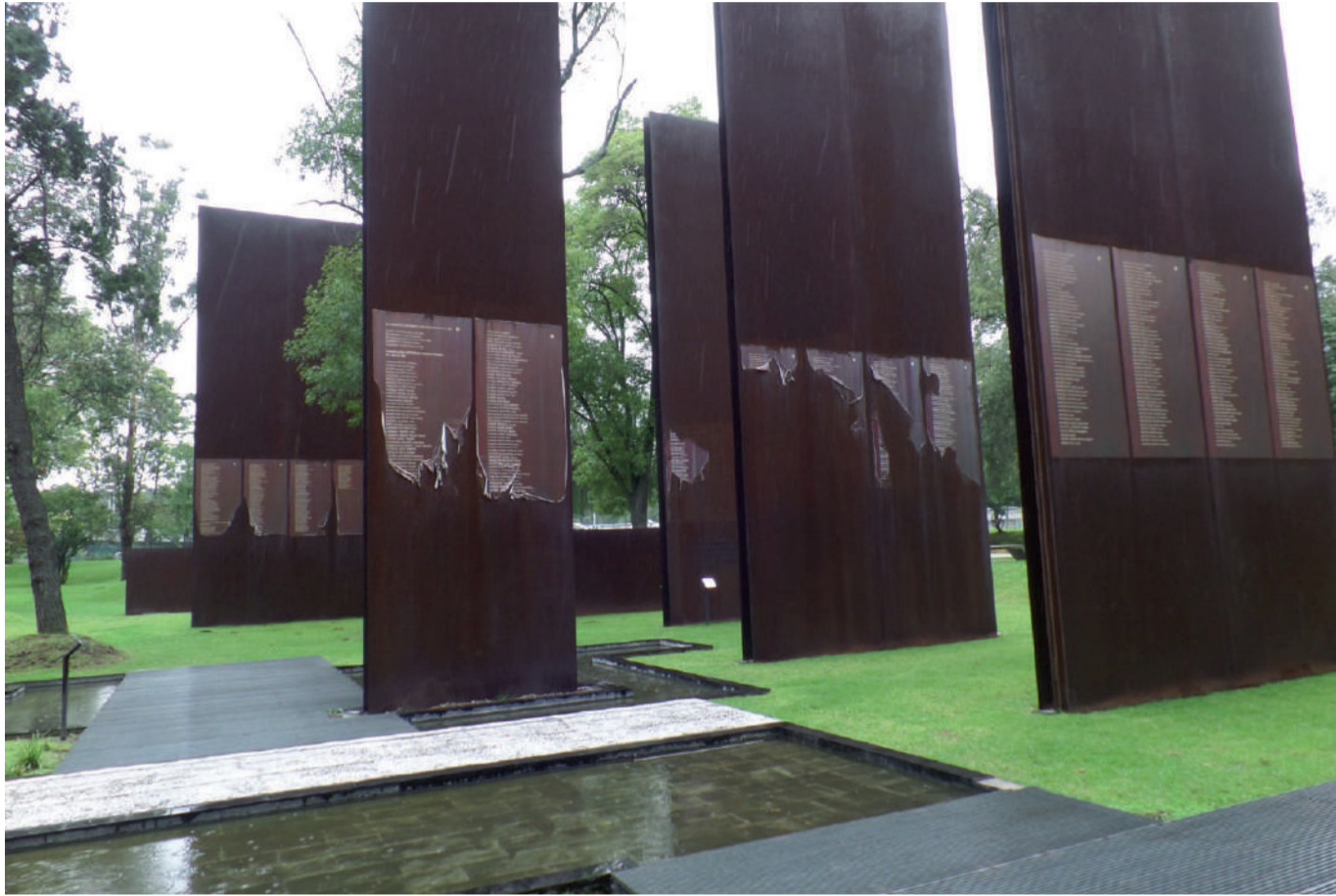
Fig. 4. Arqs. Julio Gaeta, Luby Springall, Memorial a las víctimas de la violencia en México. Ciudad de México. Deterioro de la lista de nombre adheridos a los muros de acero corten. © Fotografía: Fabricio Lázaro Villaverde, 2018.
