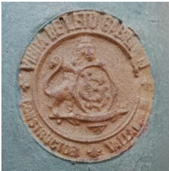
Bajante en Calle Teresa Gil (Valladolid) 45
