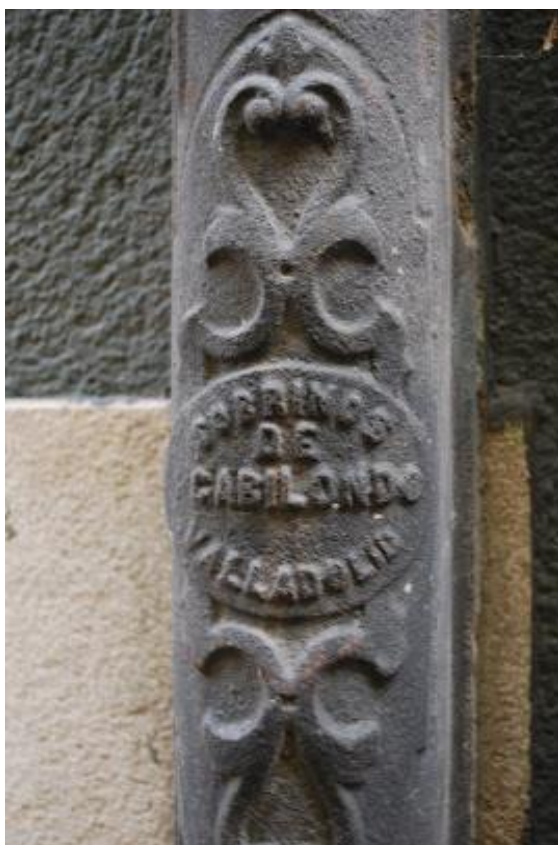
Bajante en Calle Claudio Moyano (Valladolid)
