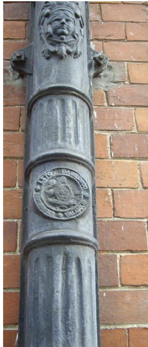
Bajante en Paseo de los Filipinos (Valladolid)
