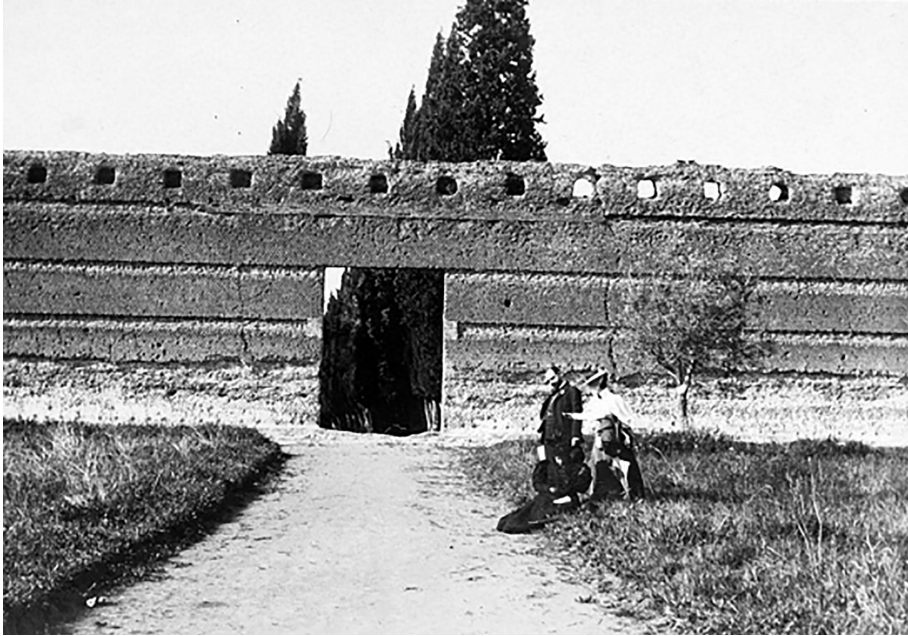
Fig. 2. Antiguas postales de Villa Adriana. Abertura en el muro di spina del Pecile. Vista del lado sur con el camino de cipreses al fondo. Década 1890.
