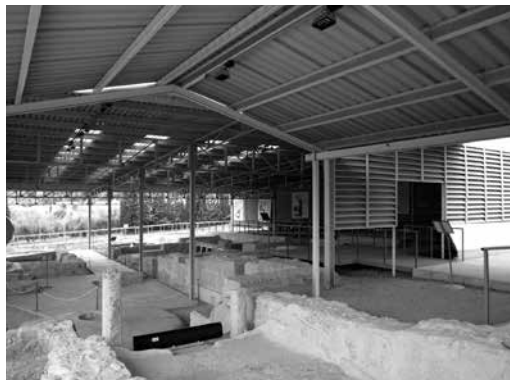
Fig. 7. Vista del acceso desde el fin de la visita y de las distintas cubiertas. Foto de la autora
