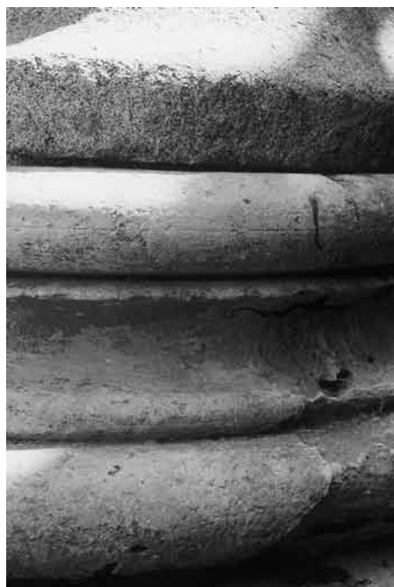
Fig. 6. Línea de replanteo en basa ática
