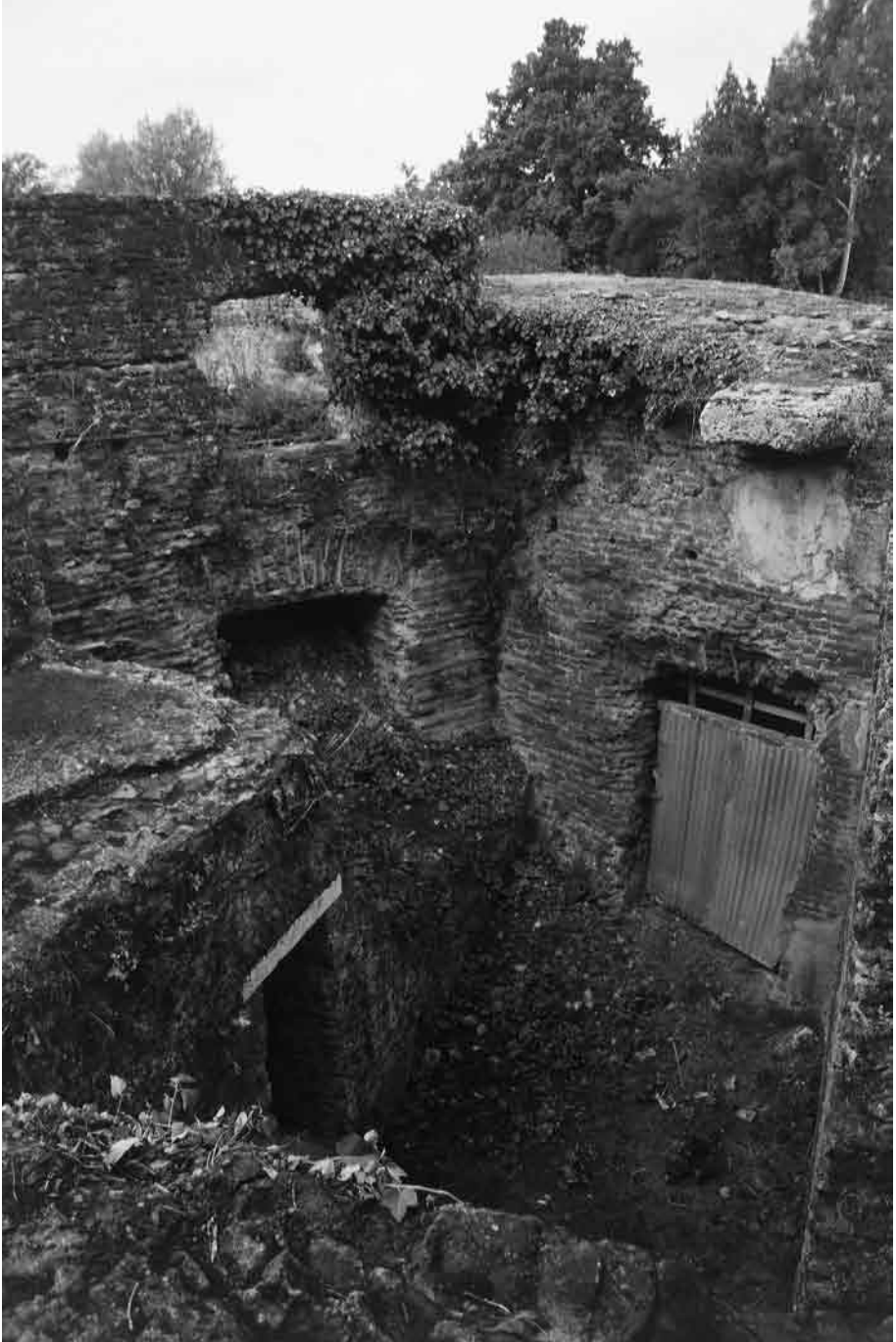
Fig. 16. Acceso Este a la galería anular.
