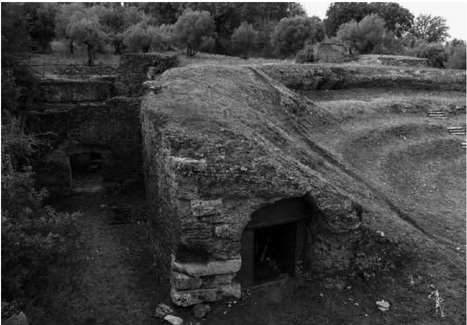
Fig. 14. Acceso Oeste de la galería anular en relación con el interior de la cavea.
