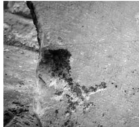
Lám. 3. Detalle del sumocapo del fuste de columna TRO68.
