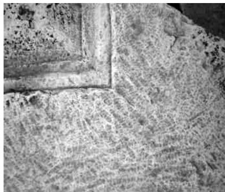
Lám. 8. Detalle de las líneas que sirvieron de guía para realizar el sofito de la pieza TR023.
