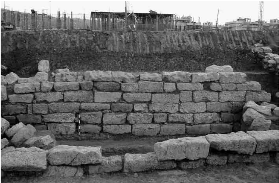
Lámina 13. Muro Norte del vado del sector NO.
