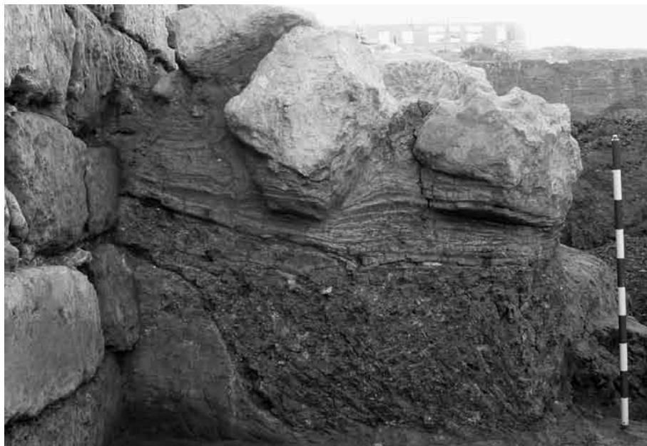
Lámina 16. Detalle del derrumbe del muro norte del puente sobre las deposiciones fluviales.
