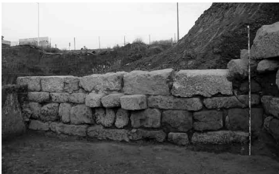
Lámina 15. Muro norte con sillarejos atizonados para sostener la estructura lígnea.
