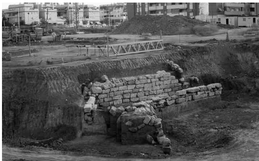
Lámina 18. Vista desde el SO de la estructura petrea del puente localizado.
